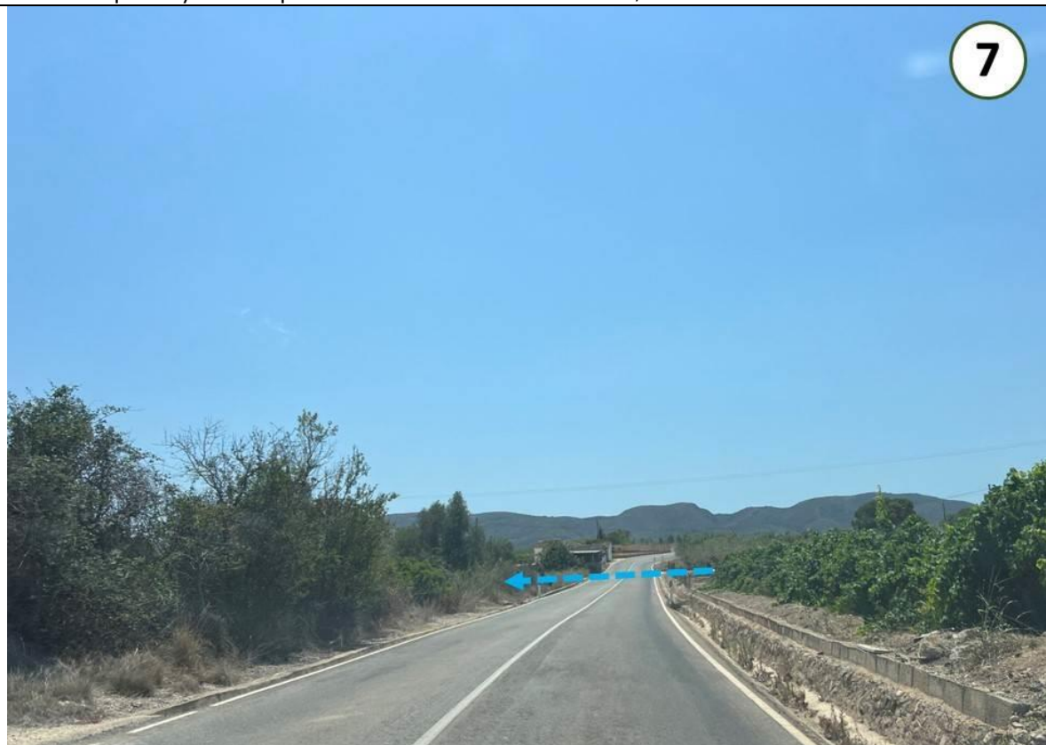
Vista de la carretera CV-738 punto que cruza la vaguada de la cuenca Este (2), en el límite municipal entre Dénia y Gata de Gorgos.
